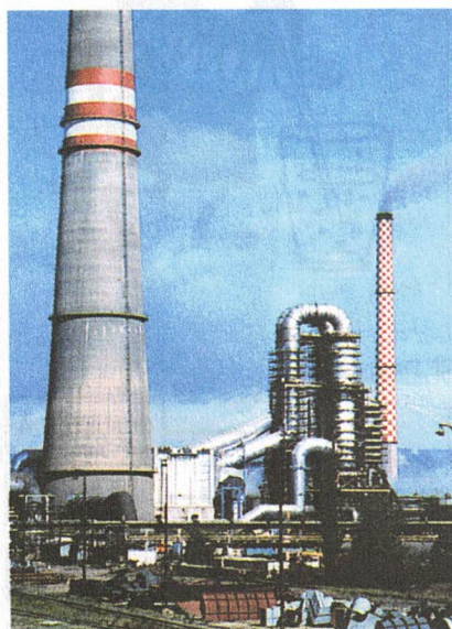
71 Odsiřovací zařízení elektrárny (Tušimice II)
